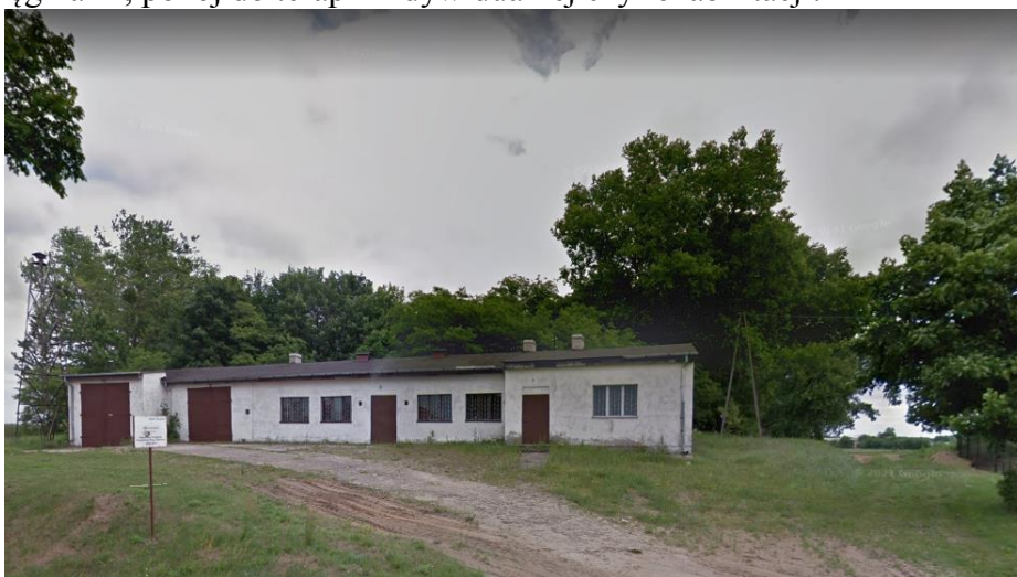
Fot. Budynek remizy przed przebudową
