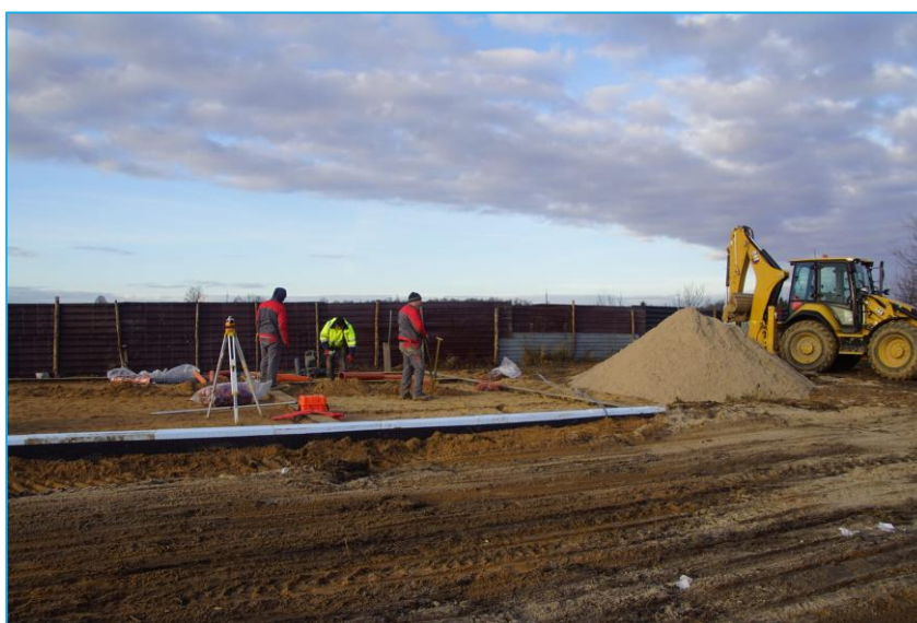
Teren budowy (grudzień 2022 r.)
