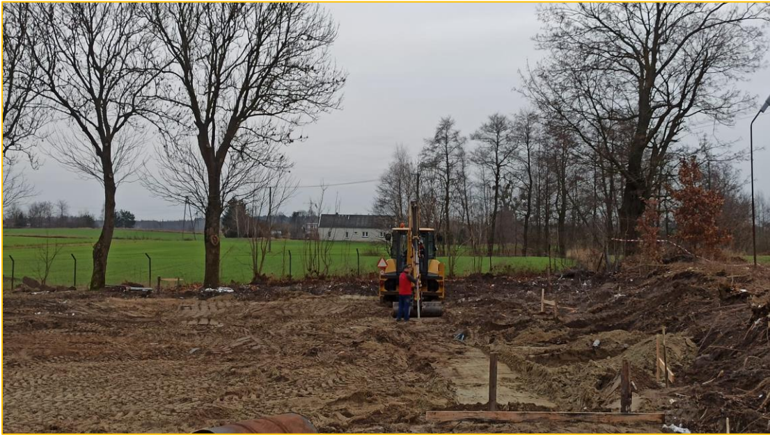
Teren budowy (grudzień 2022 r.)
